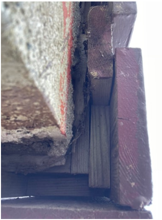
Kledning uten lufting
