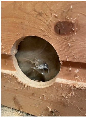
Dampsperre i vegg
