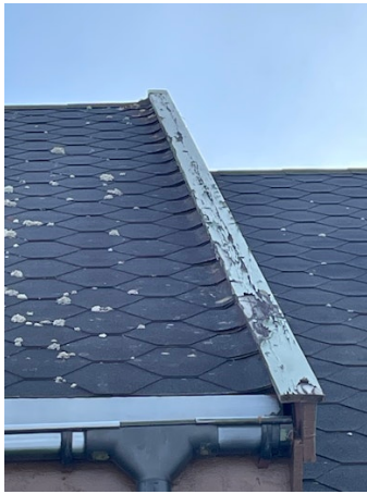
Fuktskade vannbord
