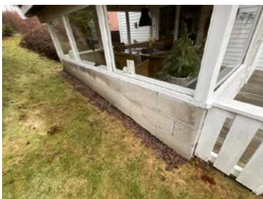
Ikke puss på blokkene.
