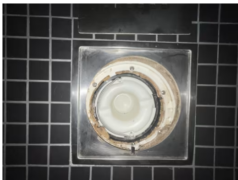
Viser sluk i dusjsonen.
