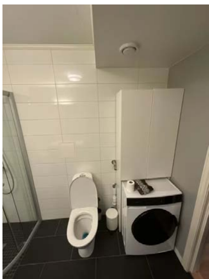
Viser gulvstående toalett og opplegg for vaskemaskin.
