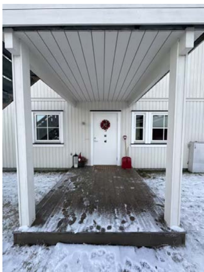
Overbygd tak ved inngangspartiet, impregnert tregulv, størrelse er ca. 6 m 2 .
