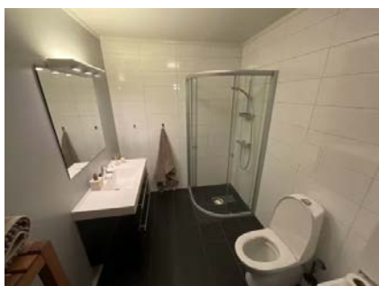
Viser installasjoner på bad.
