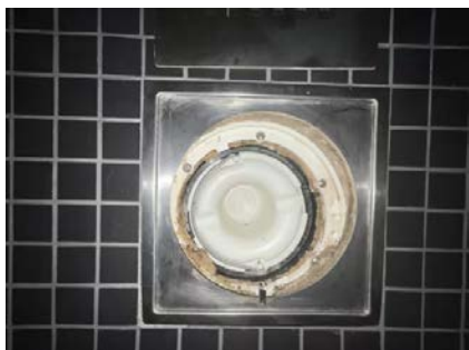
Viser sluk i dusjsonen.
