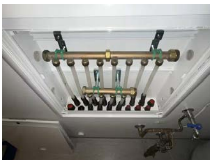
Vannrør med rør i rør system fra fordelerskap plassert teknisk rom frem til
