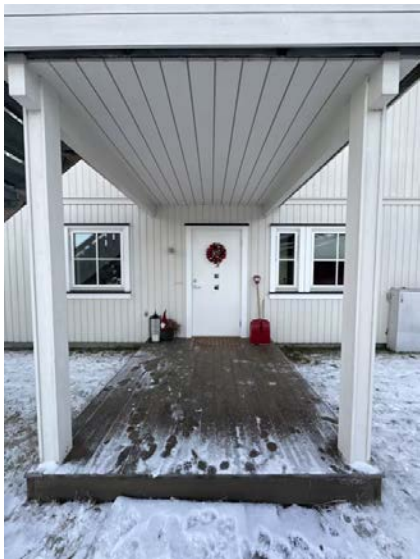
Overbygd tak ved inngangspartiet, impregnert tregulv, størrelse er ca. 6 m².
