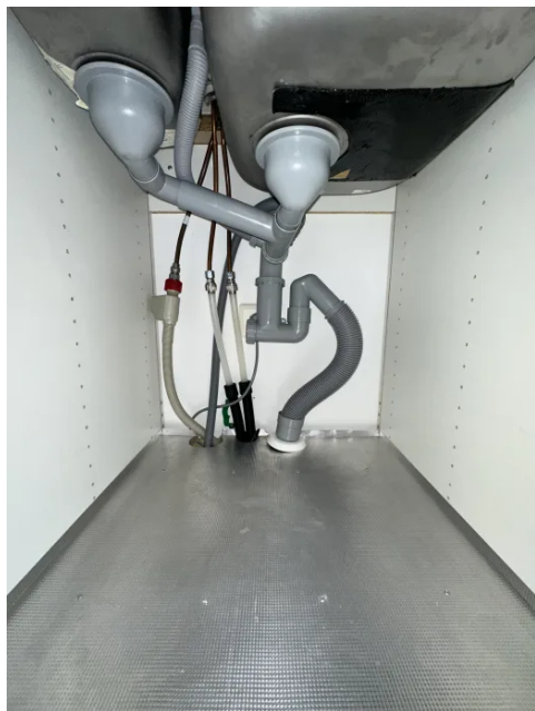
Viser vann og avløpsinstallasjoner under.
