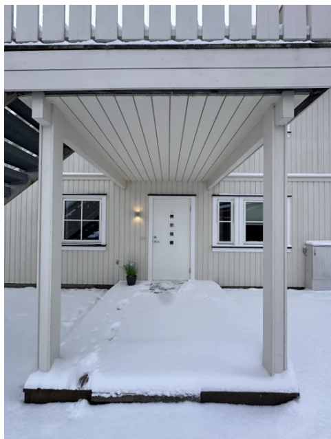
Overbygd platting ved inngangspartiet, impregneret tregulv, størrelse er ca. 6 m 2 .
