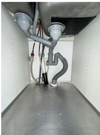
Viser vann og avløpsinstallasjoner under.
