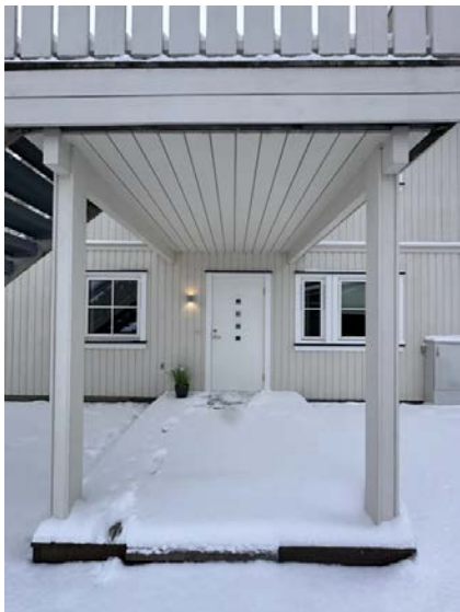
Overbygd platting ved inngangspartiet, impregnert tregulv, størrelse er ca. 6 m².
