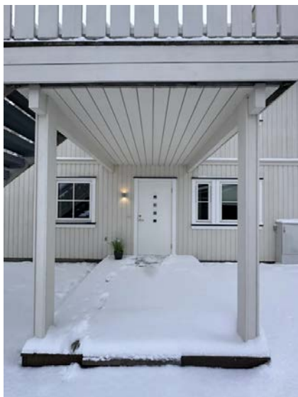
Overbygd plattform ved inngangspartiet, impregnert tregulv, størrelse er ca. 6 m 2 .
