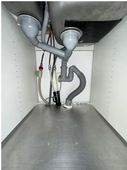
Viser vann og avløpsinstallasjoner under.
