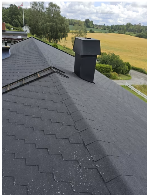
Bilde viser taktekking.
