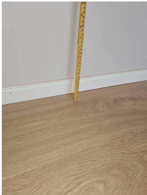
Bilde viser måling av etasjeskiller.
