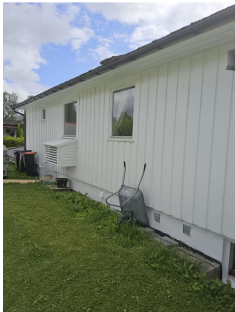
Bilde viser yttervegg.
