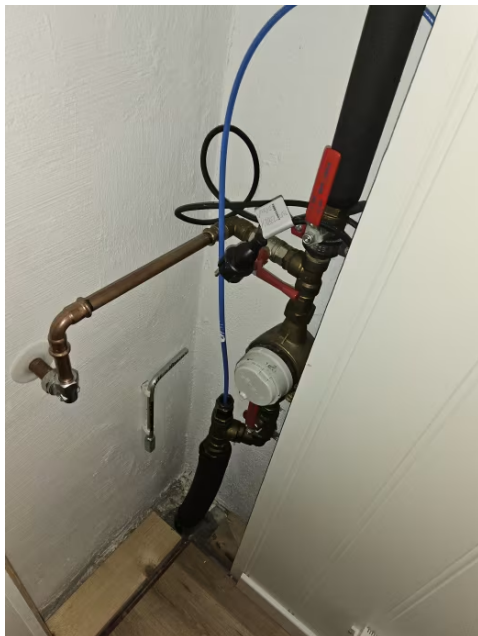
Bilde viser hovedstoppekran.
