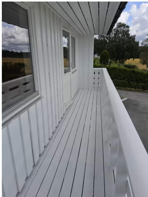
Bilde viser balkong.
