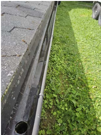
Bilde viser takrenne med motfall.
