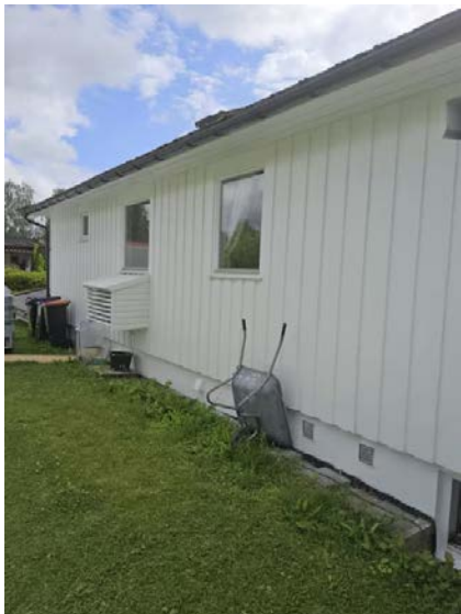
Bilde viser yttervegg.
