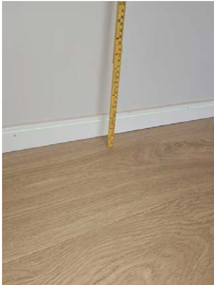
Bilde viser måling av etasjeskiller.
