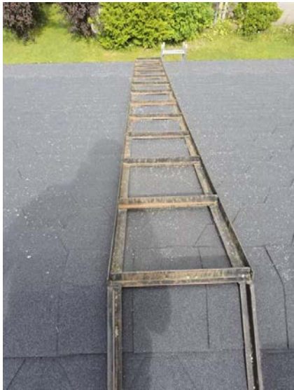
Bilde viser takstige.
