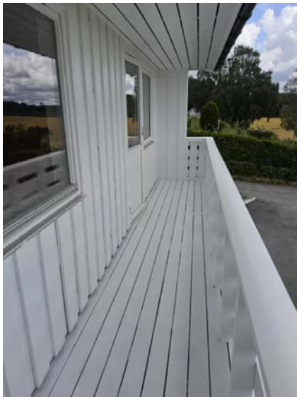
Bilde viser balkong.
