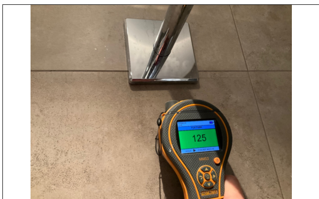
Kontrolløk med fuktmåler på alle våtrom.
