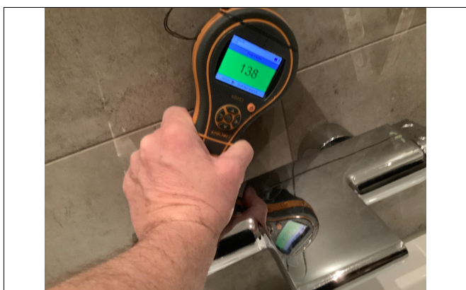
Kontrollseek med fuktmåler på alle våtrom.
