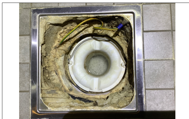
Kontroll av sluk.
