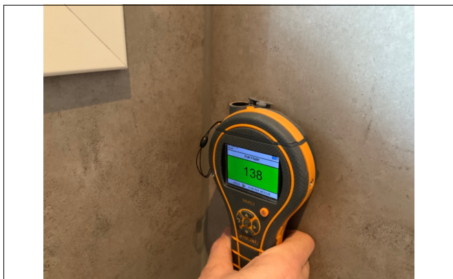
Kontrollsjøk med fuktmåler på alle våtrom.
