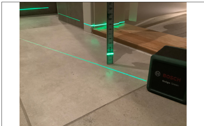
Kontroll av fall på gulv på våtrom.
