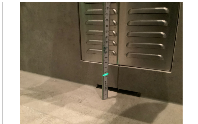
Kontroll av fall på gulv på våtrom.
