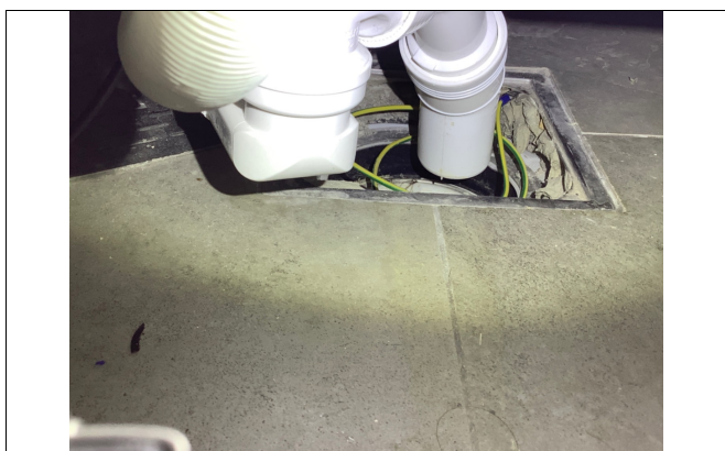
Kontroll av sluk.
