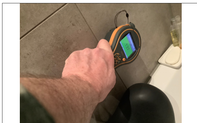
Kontrollseek med fuktmåler på alle våtrom.
