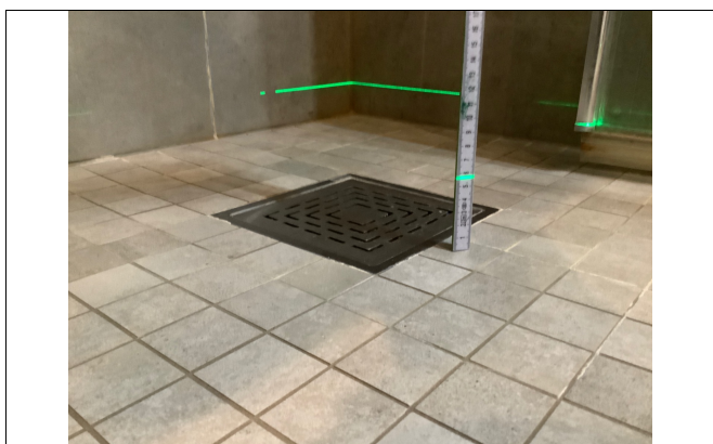
Kontroll av fall på gulv på våtrom.
