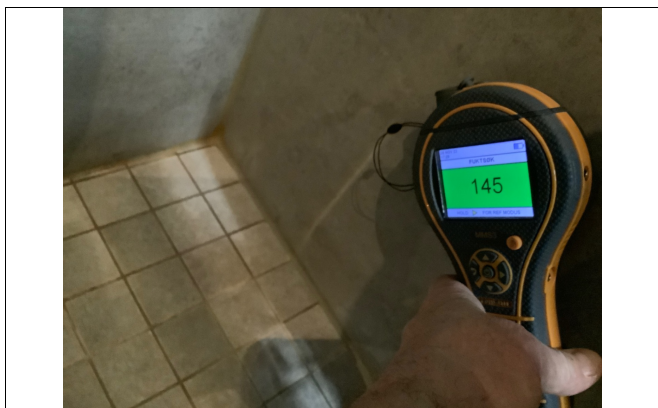
Kontroll søk med fuktmåler på alle våtrom.
