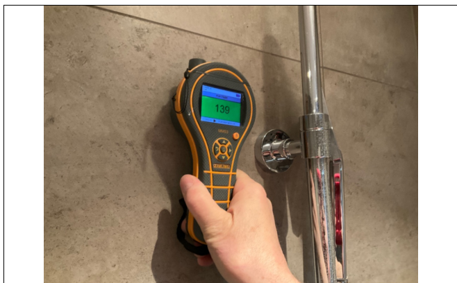
Kontrolløk med fuktmåler på alle våtrom.
