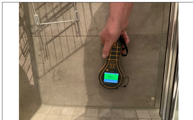
Kontrolløk med fuktmåler på alle våtrom.
