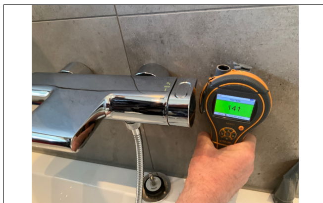
Kontrollsjøk med fuktmåler på alle våtrom.
