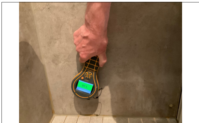
Kontrolløk med fuktmåler på alle våtrom.
