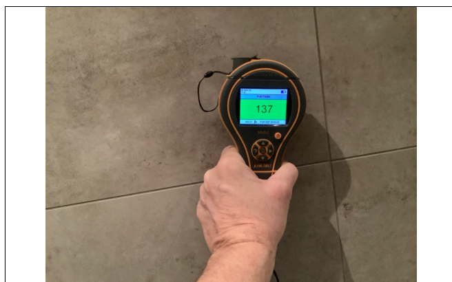
Kontrollseek med fuktmåler på alle våtrom.
