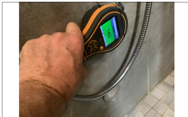
Kontroll søk med fuktmåler på alle våtrom.
