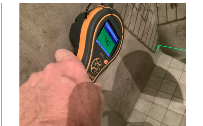
Kontrollseek med fuktmåler på alle våtrom.
