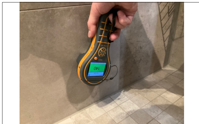
Kontrollsjøk med fuktmåler på alle våtrom.
