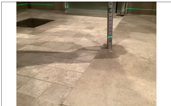
Kontroll av fall på gulv på våtrom.
