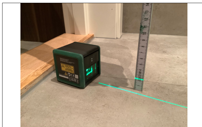
Kontroll av fall på gulv på våtrom.
