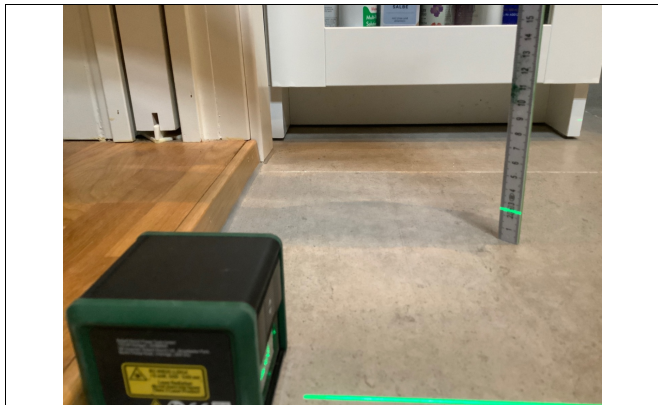
Kontroll av fall på gulv på våtrom.
