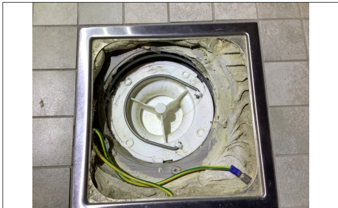
Kontroll av sluk.
