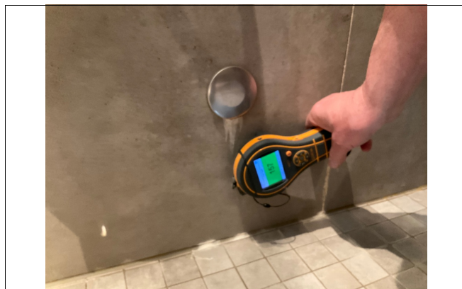
Kontrolløk med fuktmåler på alle våtrom.
