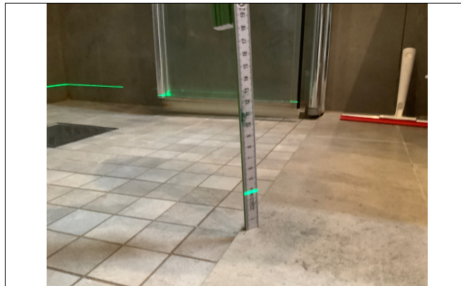
Kontroll av fall på gulv på våtrom.
