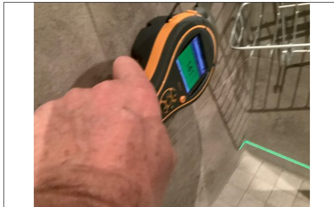
Kontrollseek med fuktmåler på alle våtrom.
