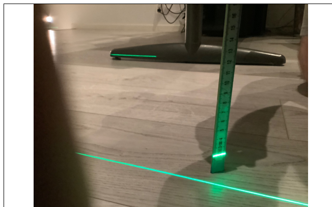
Nivellering av gulv og kontroll av evt. skjevheter.
