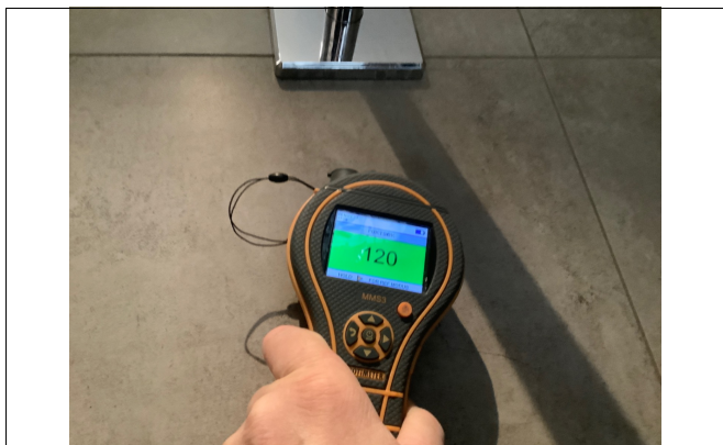
Kontroll søk med fuktmåler på alle våtrom.
