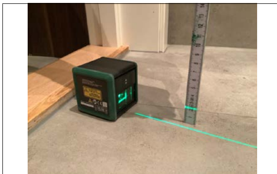
Kontroll av fall på gulv på våtrom.
