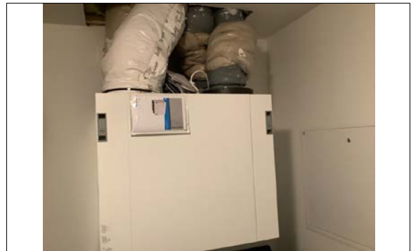
Balansert ventilasjon.
