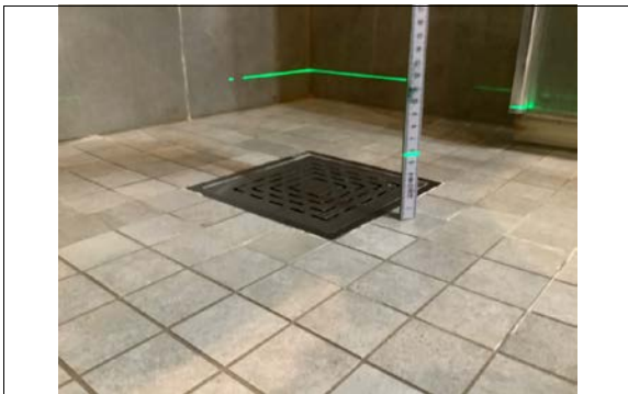
Kontroll av fall på gulv på våtrom.
