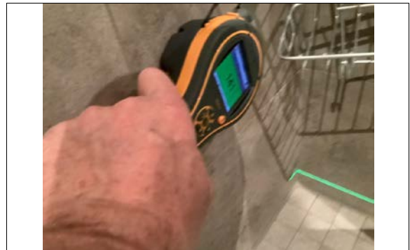
Kontrolløk med fuktmåler på alle våtrom.
