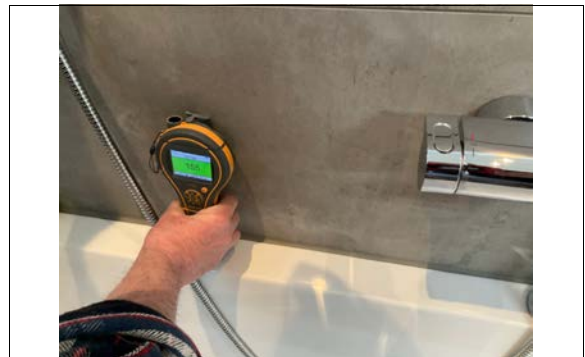
Kontrolløk med fuktmåler på alle våtrom.
