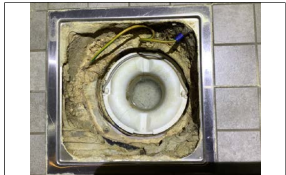
Kontroll av sluk.
