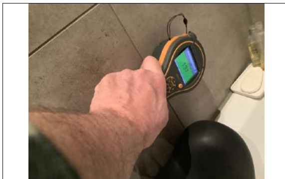
Kontrollseek med fuktmåler på alle våtrom.
