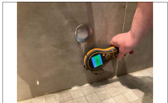
Kontrolløk med fuktmåler på alle våtrom.
