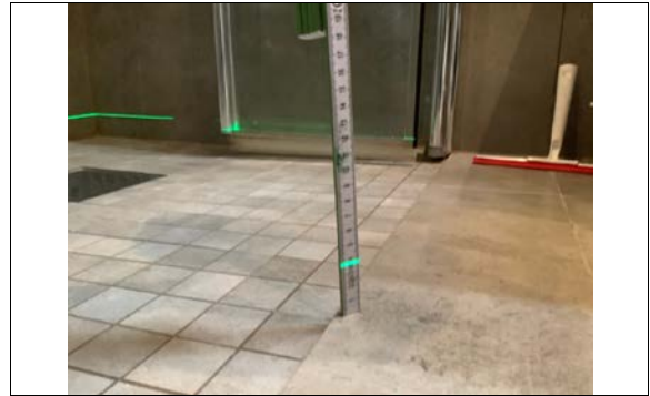
Kontroll av fall på gulv på våtrom.
