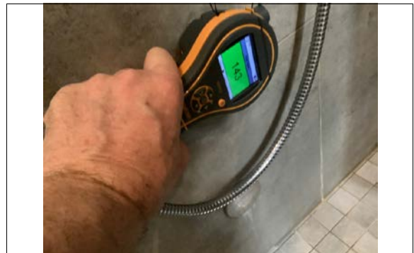
Kontroll med fuktmåler på alle våtrom.
