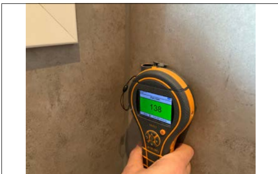
Kontrolløk med fuktmåler på alle våtrom.
