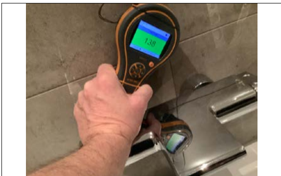
Kontrollseek med fuktmåler på alle våtrom.
