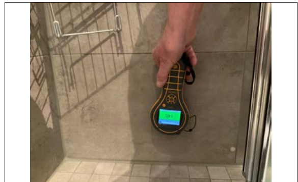
Kontrolløk med fuktmåler på alle våtrom.
