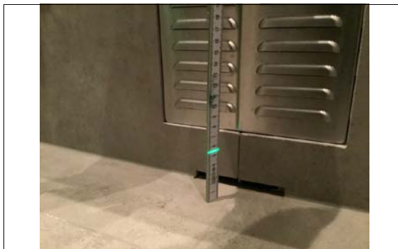
Kontroll av fall på gulv på våtrom.
