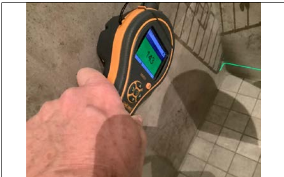
Kontrolløk med fuktmåler på alle våtrom.
