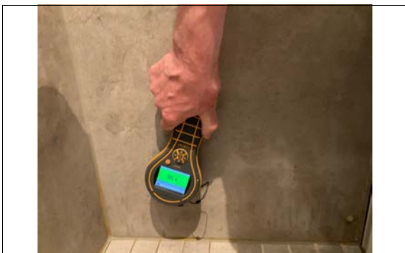
Kontrolløk med fuktmåler på alle våtrom.
