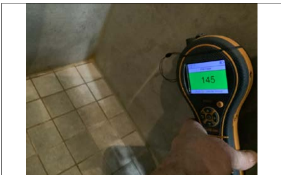
Kontrollsløk med fuktmåler på alle våtrom.
