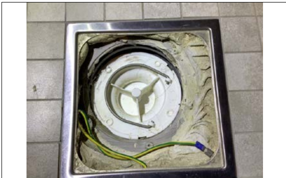
Kontroll av sluk.
