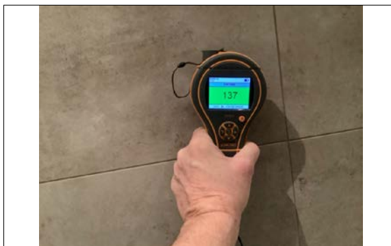
Kontrollseek med fuktmåler på alle våtrom.
