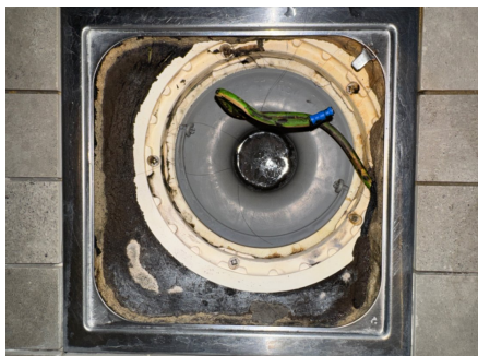
Plastsluk med klemring og synlig membran
