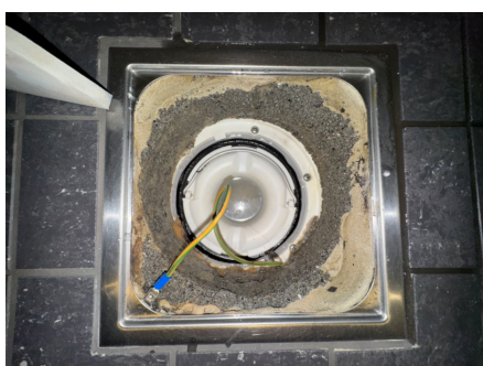
Plastsluk med klemring og synlig mansjett
