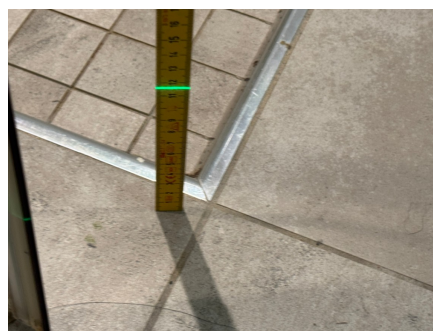
Fallforhold ca. 115 mm overkant gulv ved dusjsone
