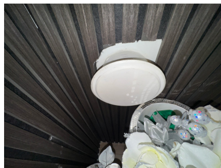
Pipeløpet er kledd inn i 1.etg
