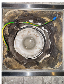
Plastsluk med klemring og synlig membran/mansjett
