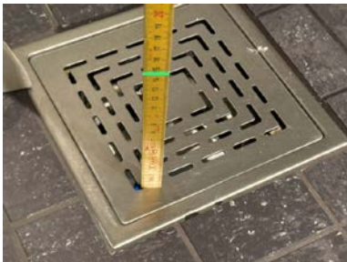
Fallforhold ca. 145 mm topp slukrist i dusjsone
