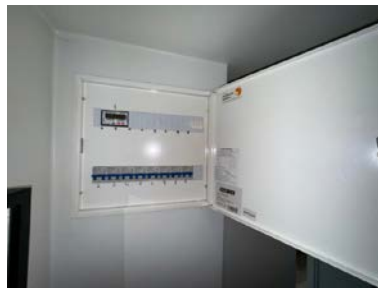
Sikringsskap hybel
