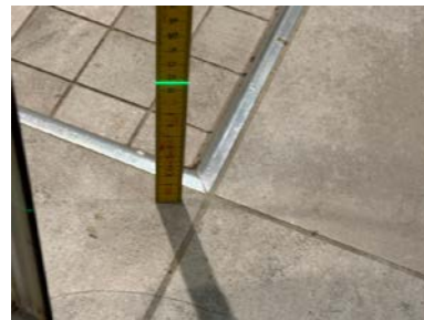
Fallforhold ca. 115 mm overkant gulv ved dusjsone
