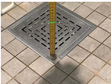
Fallforhold ca. 146 mm topp slukrist i dusjsone
