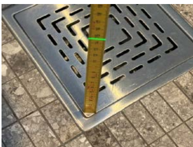
Fallforhold ca. 145 mm topp slukrist i dusjsone
