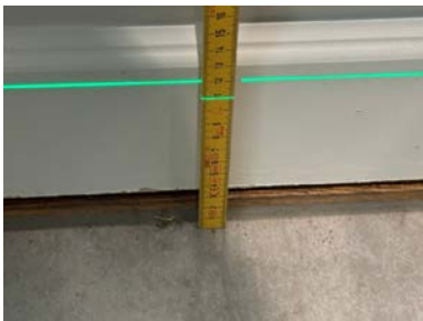
Fallforhold ca. 108 mm overkant gulv ved terskel
