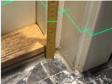
Fallforhold ca. 108 mm overkant gulv ved terskel
