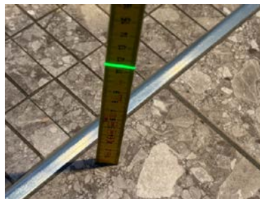
Fallforhold ca. 114 mm overkant gulv ved dusjsone
