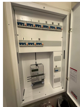
Sikringsskap med automatsikringer.
