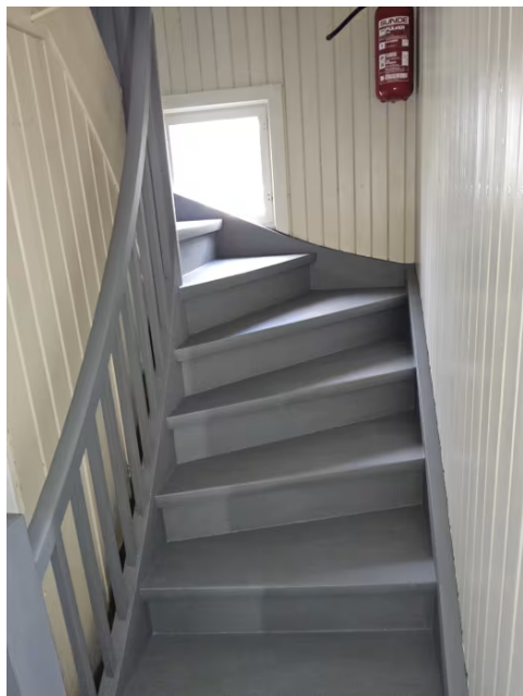
Bilde av trapp mellom 1. etasje og loftsetasje.
