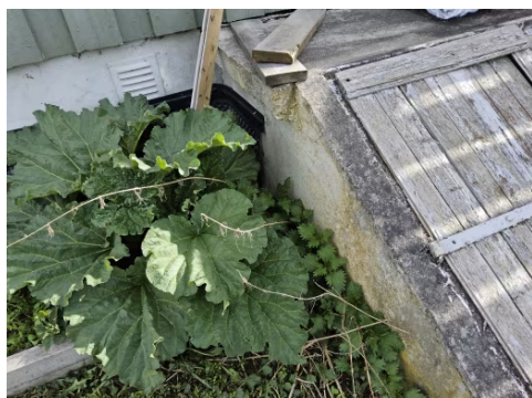
Knotteplast er avsluttet mot kjellerinnngang
