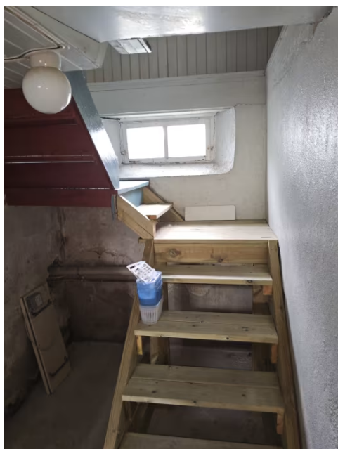
Åpen tretrapp mellom kjelleretasje og 1. etasje.
