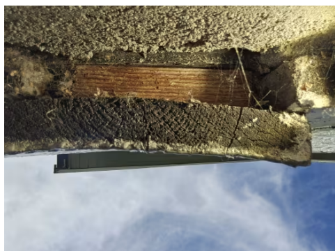
Begrenset lufting bak trekledningen.
