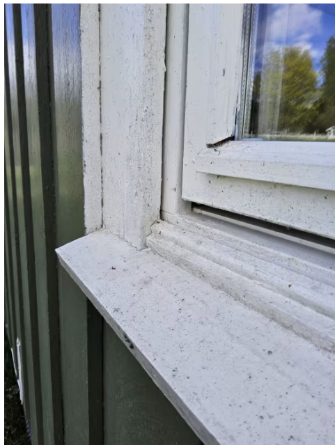
Vindusommramming er avsluttet tett mot vannbord.
