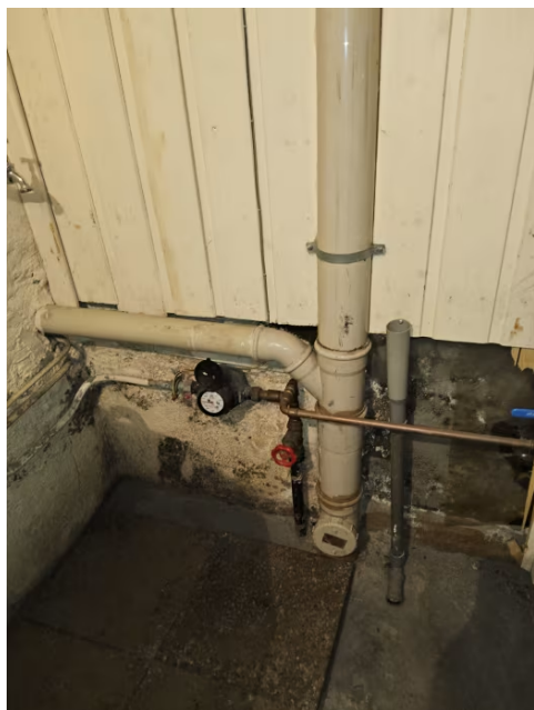
Boligen har i hovedsak synlige avløpsrør av plast.
