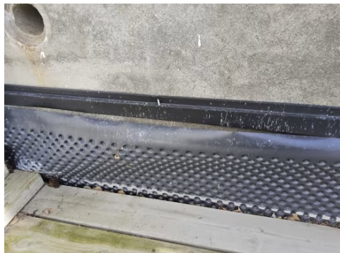
Knotteplast har løsnet fra topplist.
