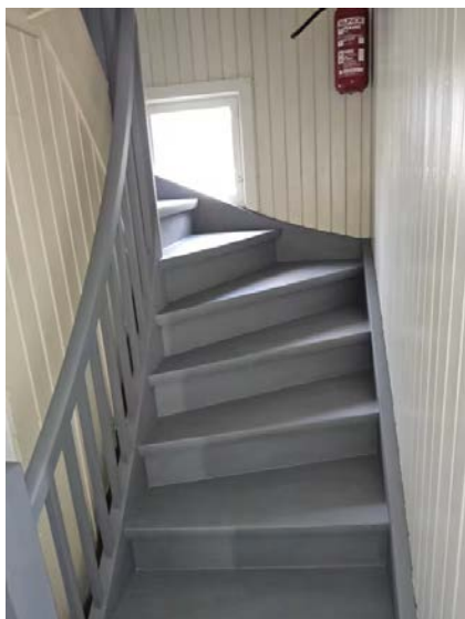
Bilde av trapp mellom 1. etasje og loftsetasje.
