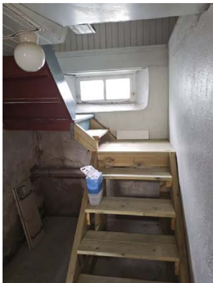
Åpen tretrapp mellom kjelleretasje og 1. etasje.
