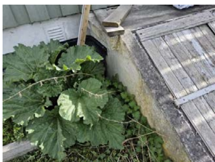
Knotteplast er avsluttet mot kjellerinngang
