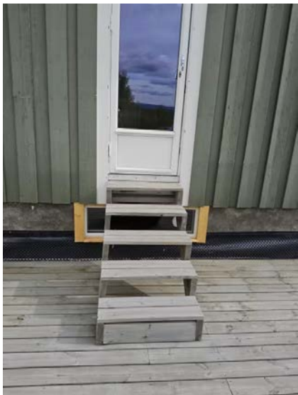
Enkel tretrapp uten rekkverk fra stue til terrasse.
