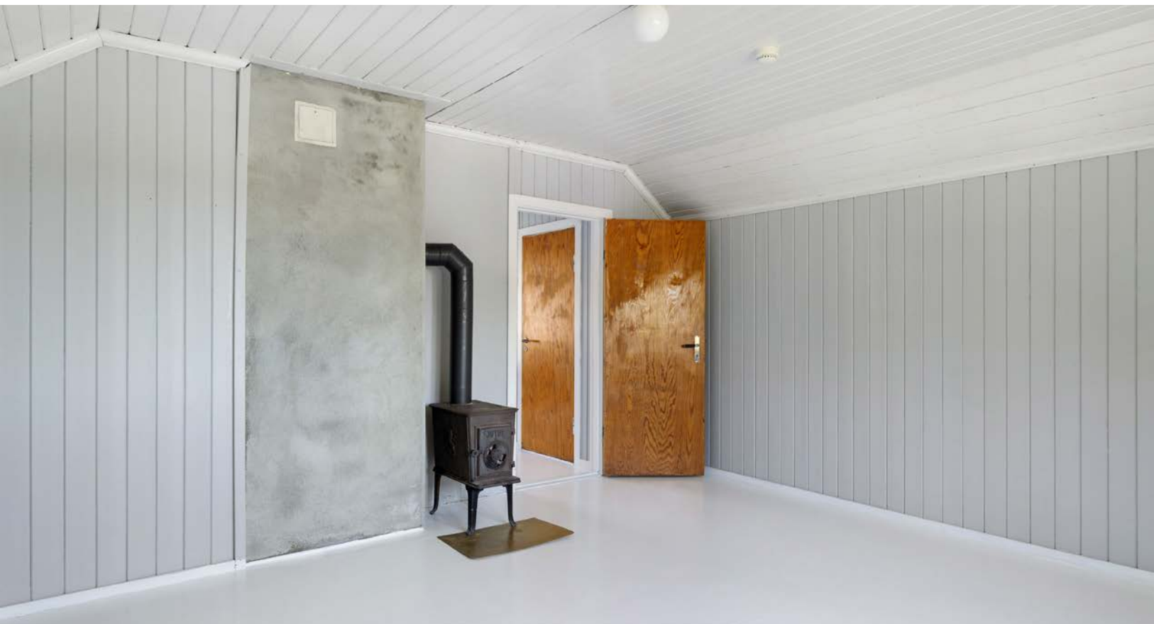
Soverom i 2. etasje med montert vedovn.
