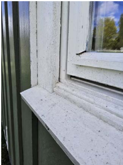
Vindusommramming er avsluttet tett mot vannbord.
