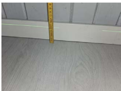
Etasjeskiller er kontrollert med nivelleringslaser.
