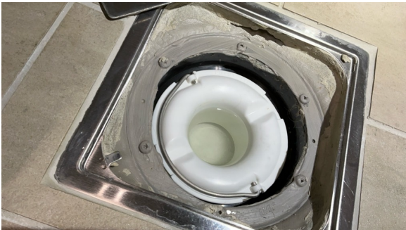
Kontroll av sluk.
