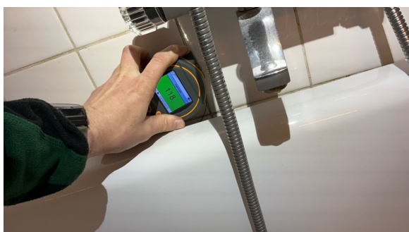
Enkle fuktsøk viste normale verdier.
