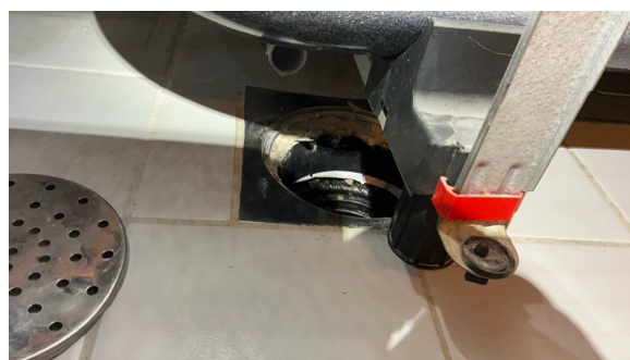
Kontroll av sluk.
