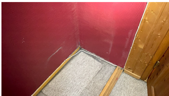
Løse ledninger registrert.
