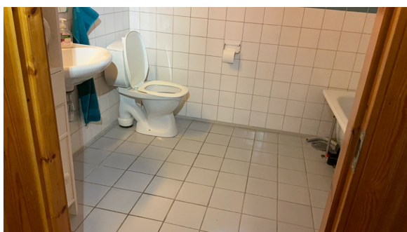
Oversiktsbilde av bad.
