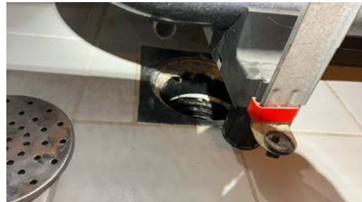
Kontroll av sluk.
