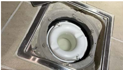
Kontroll av sluk.
