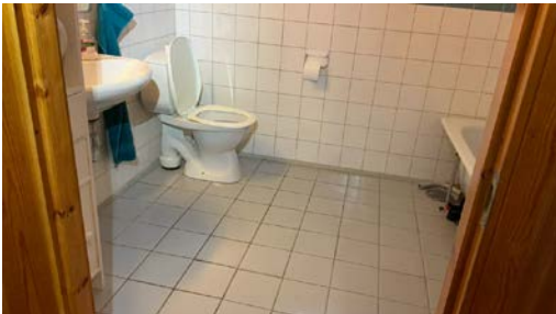
Oversiktsbilde av bad.
