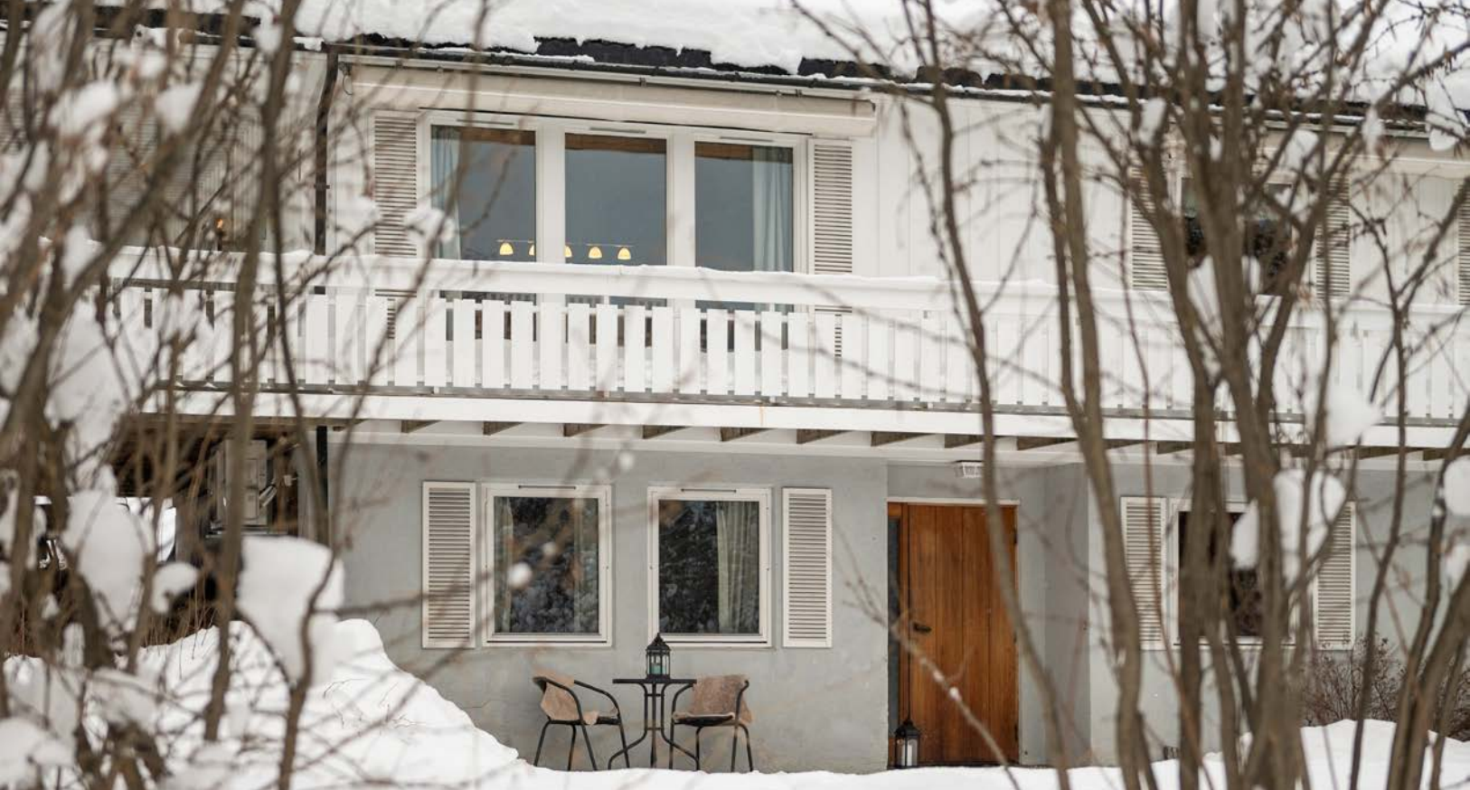
Inntrukket inngangsparti i underetasjen.
