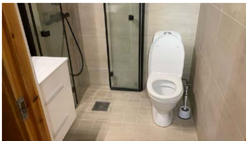
Oversiktsbilde av bad.
