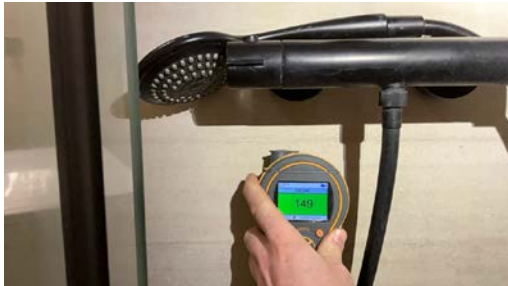
Enkle fuktsøk viste normale verdier.
