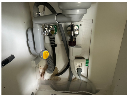
Røropplegg i kjøkkenbenk med Waterguard
