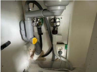
Rørapplegg i kjøkkenbenk med Waterguard
