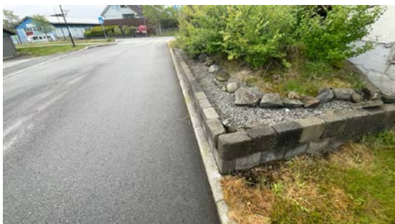
Forskyvning på enkelte steiner.
