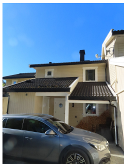
Overbygd inngangsparti på samlet ca 15 kvm. Brosteinsbelagt terreng.
