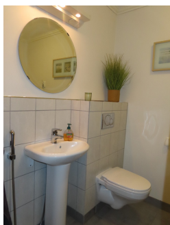
Vaskerom/toalettrom, kombinert rom med tekniske installasjoner.
