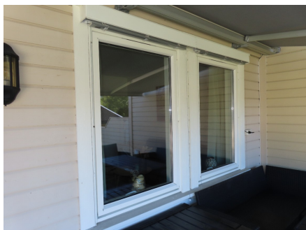
Vinduer i stue- Begge som åpningsvidnuer med spalteventil i overkarm.
