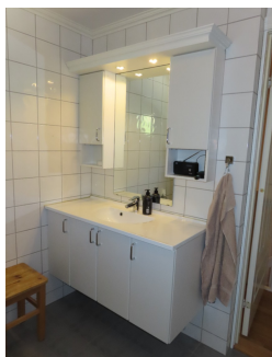
Del av dusjbad - servantskap med helstøpt servantplate.
