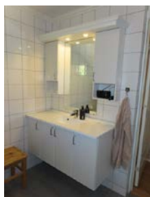
Del av dusjbad - servantskap med helstøpt servantplate.
