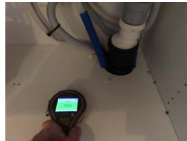
Fuktsøk i benkeskap - ingen påviste forhøyede fuktverdier.
