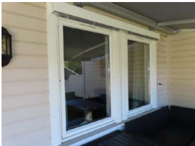
Vinduer i stue- Begge som åpningsviduer med spalteventil i overkarm.
