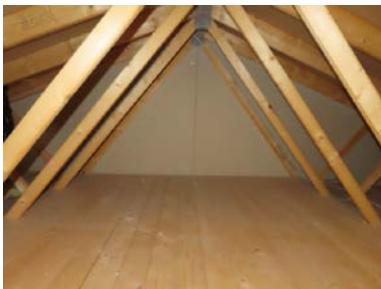
Del av lagerplass på kaldloftet.
