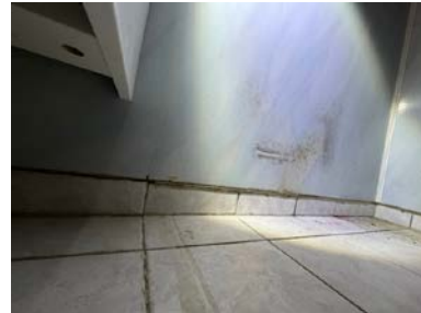
Det er ikke aluminiumslist i hele våtsonen.
