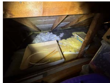
Takkonstruksjonen er begrenset ventilert.
