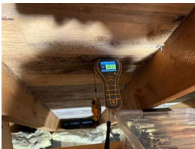
Fuktmåling på kaldloftet.
