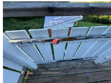
Råteskadet rekkverk.
