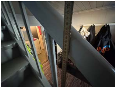
Høyden på rekkverket.
