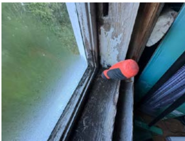
Råteskade i vindu på loftet.
