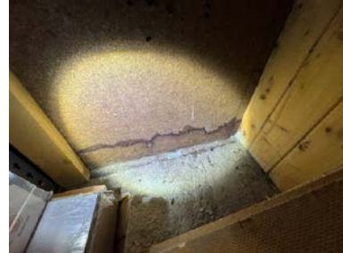
Fuktmerker på vegg inne på boden.
