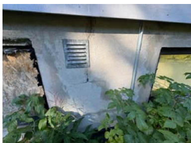
Eksempel på sprekk i grunnmuren.
