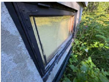
Råteskade i vindu på loftet.
