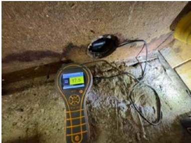
Fuktmåling i veggen på boden ved fuktskjold.
