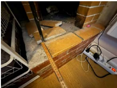
Det er ikke ildfast plate på gulvet under ildstedet.
