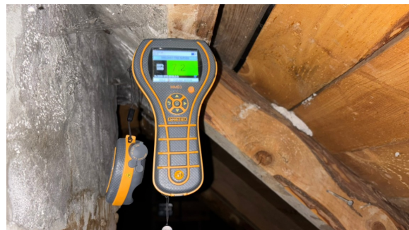
Ingen tegn til forhøyde fuktverdier ved befaringen
