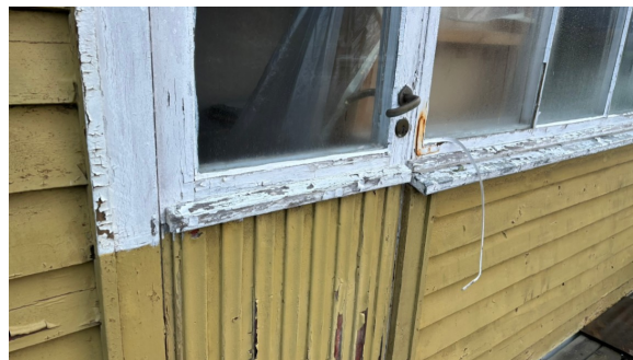
Balkongdør av eldre dato
