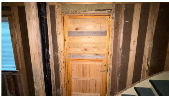
Ytterdøren er en eldre tredør
