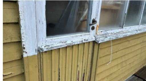
Balkongdør av eldre dato
