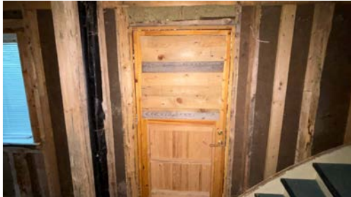
Ytterdøren er en eldre tredør
