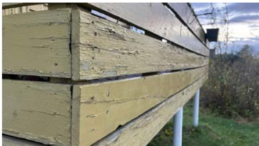
Værslitte rekkverksbord
