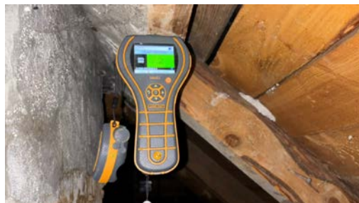
Ingen tegn til forhøyde fuktverdier ved befaringen
