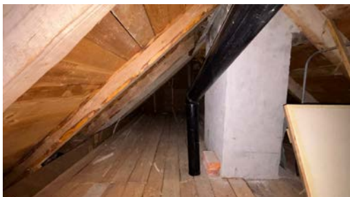
Takkonstruksjon fremstår i god stand
