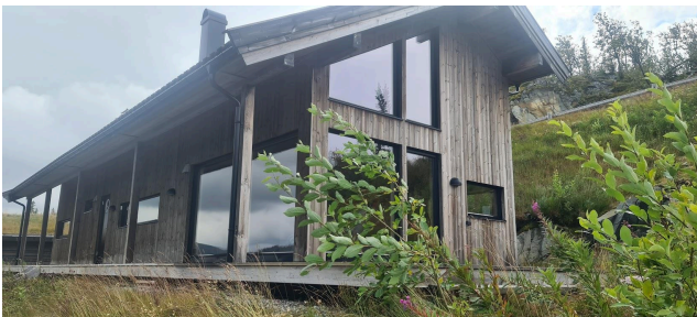
Fasade med terrasse på lang - og gavl vegg.
