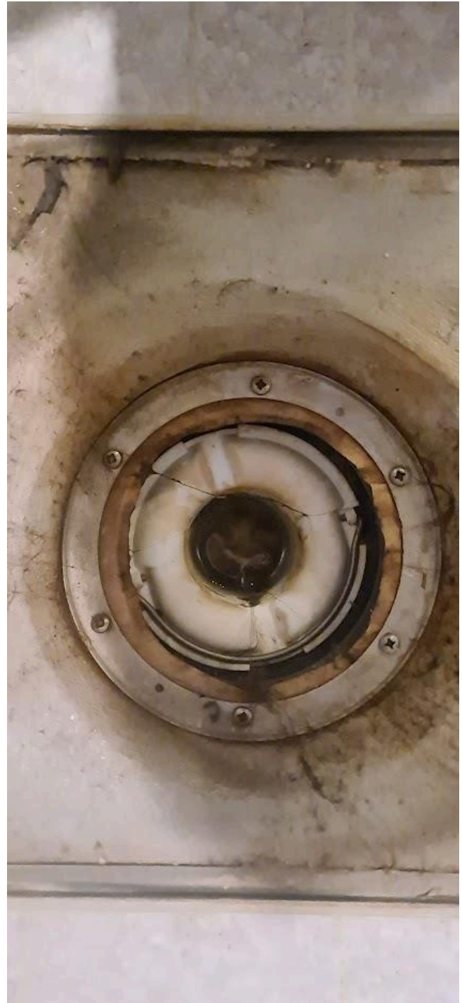
Synlig slukmansjett i sluk, men skade i sluk potte. Eier opplyser at sluk potte er byttet pr.24.10.24.
