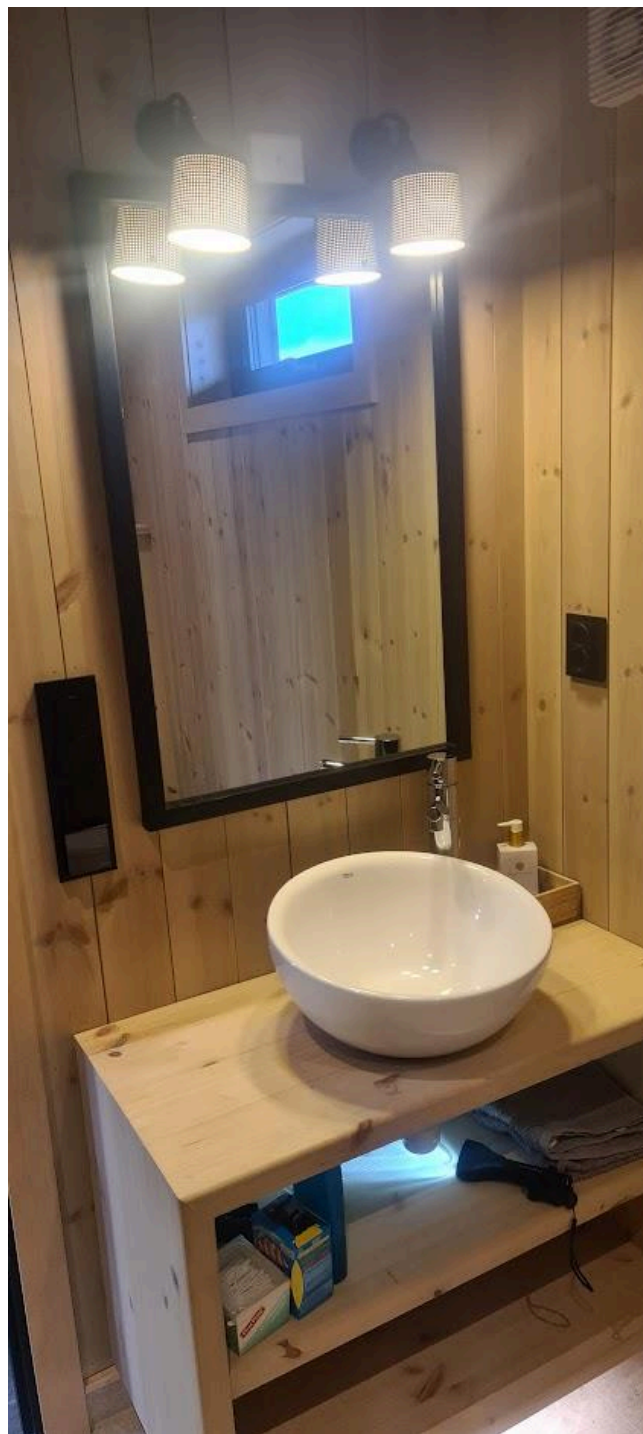
Servant montert opp på skap med speil over.
