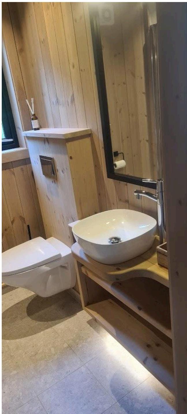
Servant montert opp på skap/hyller med vegg toalett plassert ved siden.
