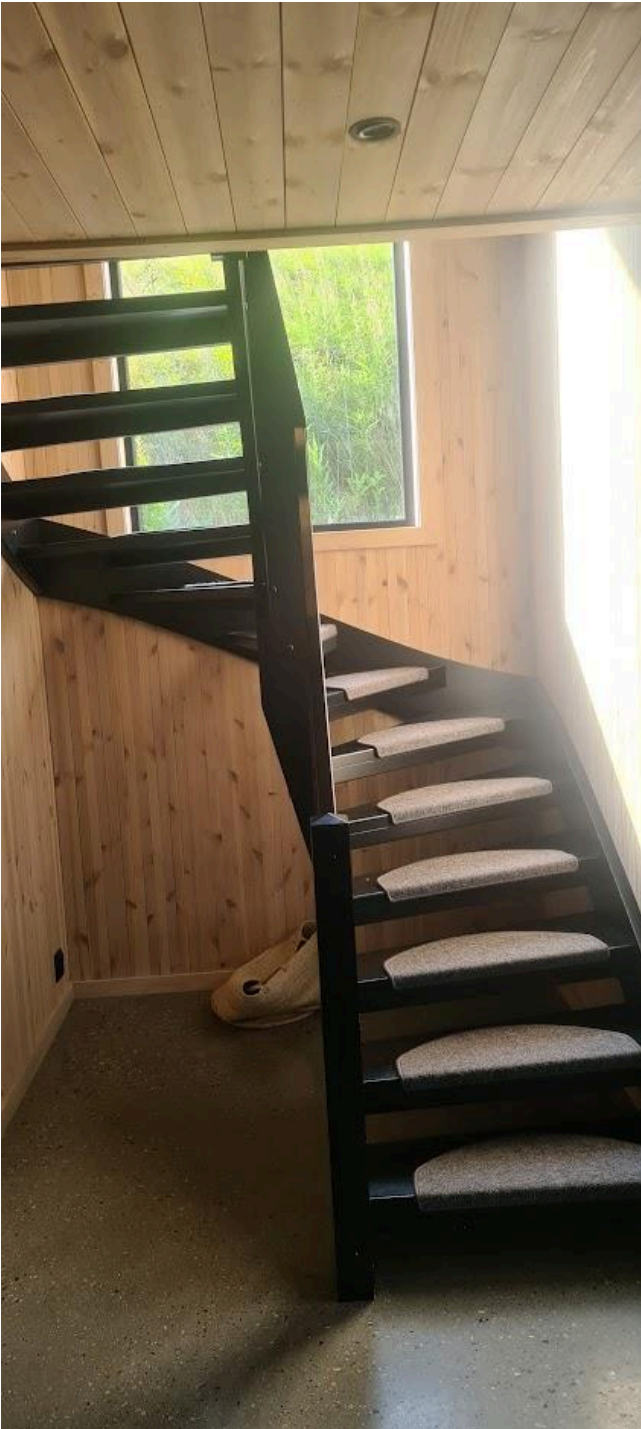
Åpen sort malt trapp til Loftsetasje med selvklebende trappematter i trappetrinn, men uten håndløper på vegg
