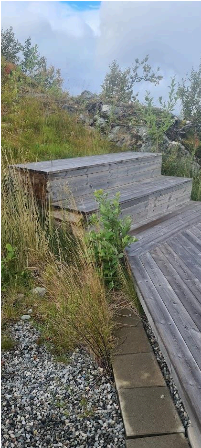
Terrasse på terreng på gavl/ende vegg med trapp opptil terreng, hvor Løkjestaulkilsvegen ligger ovenfor og nedenfor.
