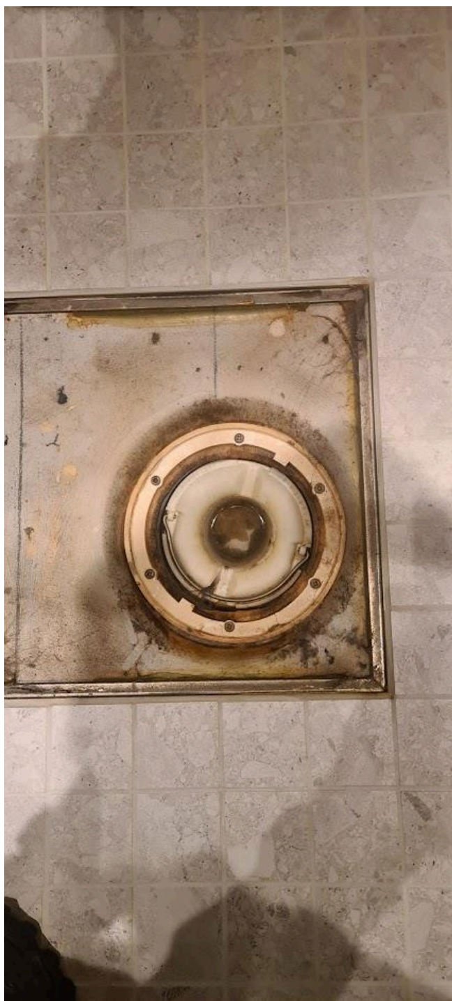
Synlig slukmansjett i sluk.
