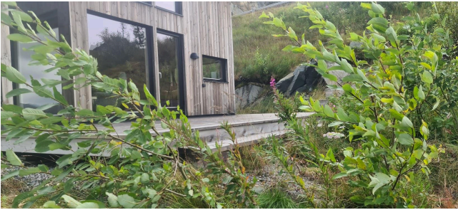
Terrasse på gavl/ende vegg med utgang fra stue.
