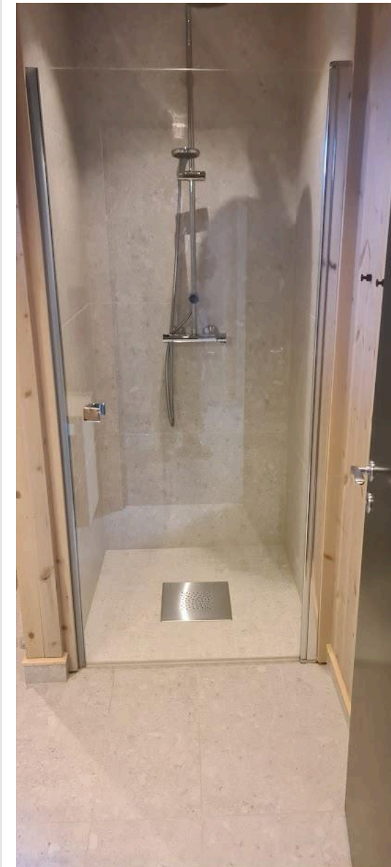
Dusj nisje med glassdør.
