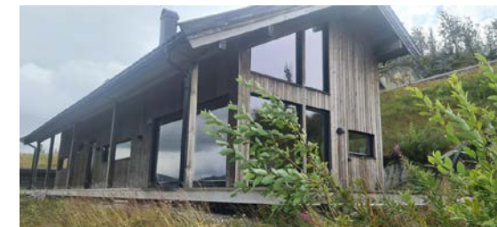
Fasade med terrasse på lang - og gavlv vegg.
