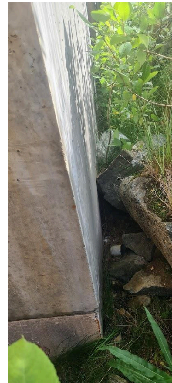
Betongvegg i yttervegg sportsbod inn mot fjellskjæring hvor en stor steinblokk står mot betongveggen.
