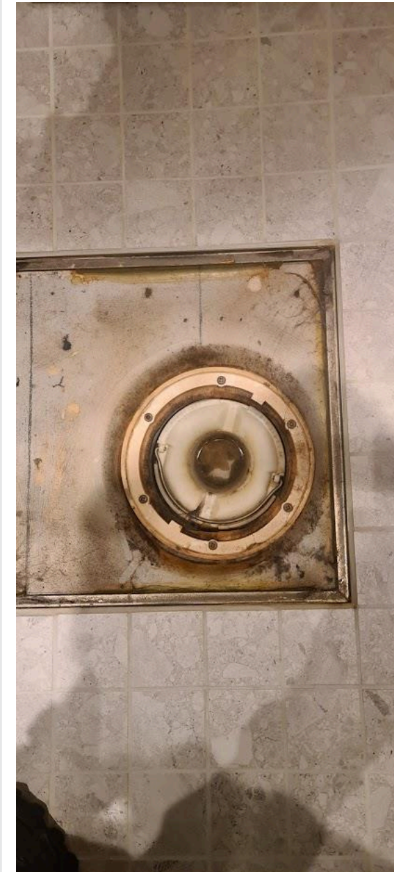
Synlig slukmansjett i sluk.
