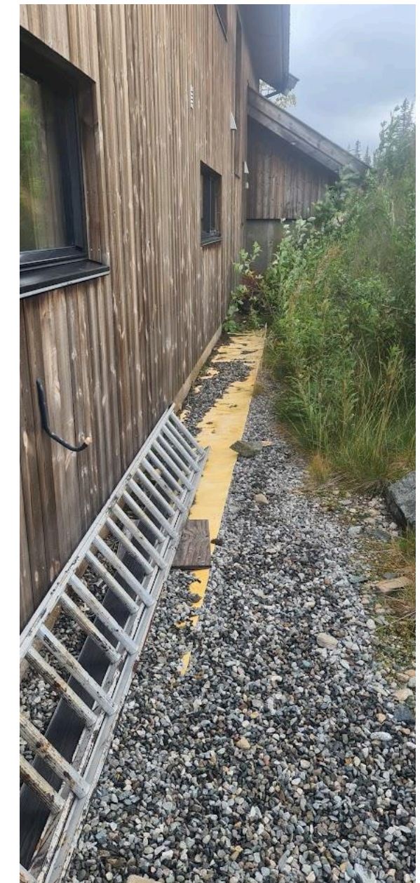
Terreng bak hytta hvor Radonduk mangler masse over radonduk.
