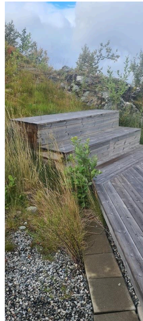
Terrasse på terreng på gavl/ende vegg med trapp opptil terreng, hvor Løkjestaulkilsvegen ligger ovenfor og nedenfor.
