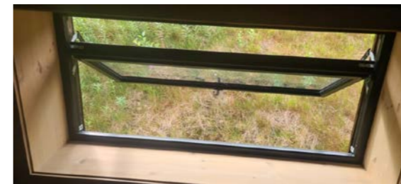
Bilde viser type vindu som er montert i soverom 2,3 og 4.
