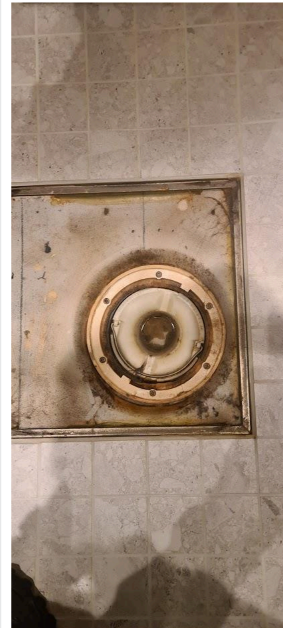
Synlig slukmansjett i sluk.
