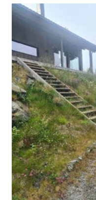
Terreng trapp fra biloppstillingsplass til inngang hytte.
