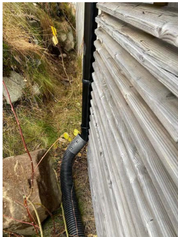
Eier sitt bilde tatt 24.10.24 hvor han montert avløpsledning fra baksiden av bod og ut i terrenget.
