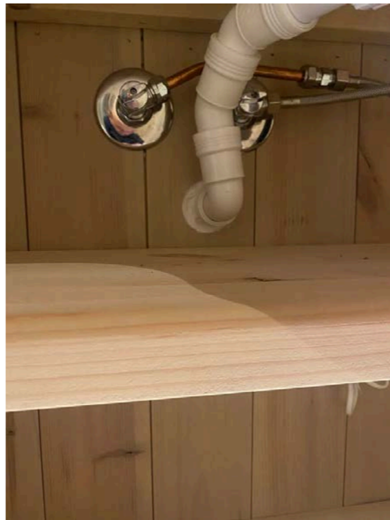
Bilde tatt av eier 24.10.24 viser elastisk fuge rundt avløpsrør.
