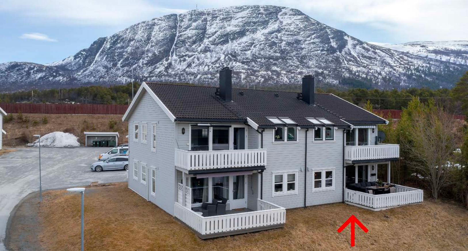
Leiligheten ligger i 1. etasje mot sør i firemannsbolig
