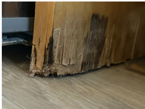
Fuktskader på et område i nedre del på et skrog.
