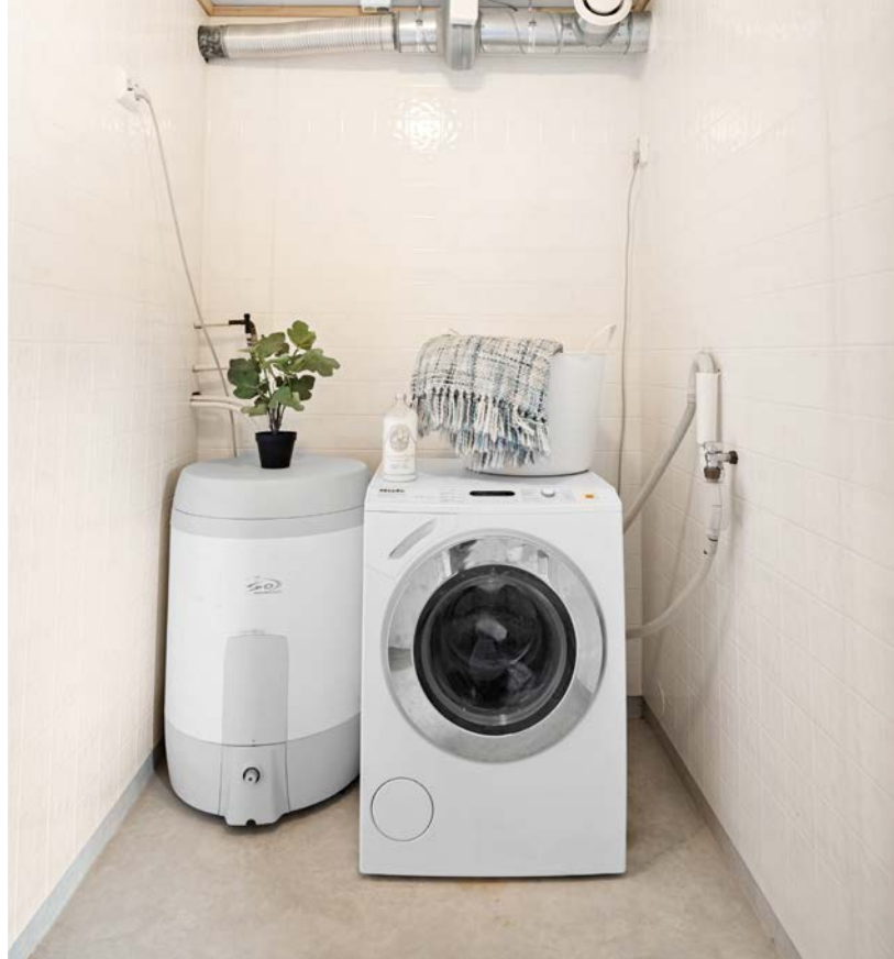
Vaskerom med plass til vaskemaskin og varmtvannsbereder
