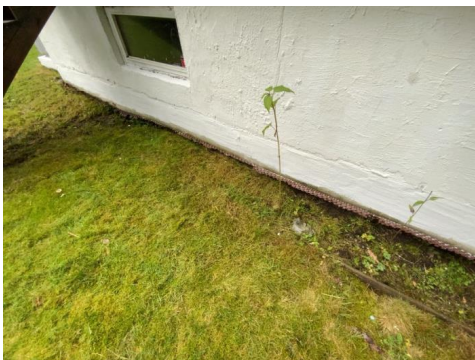
Kontroll av drenering/fuktsikring.
