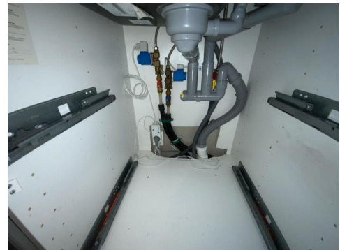
Besiktigelse av røropplegg.
