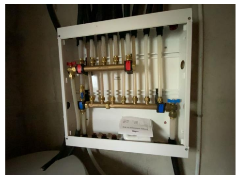
Besiktigelse av røropplegg.
