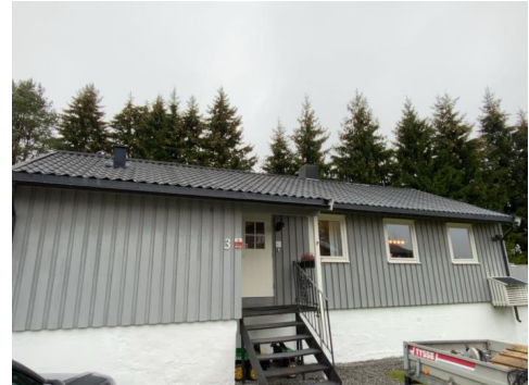
Besiktigelse av taktekke.
