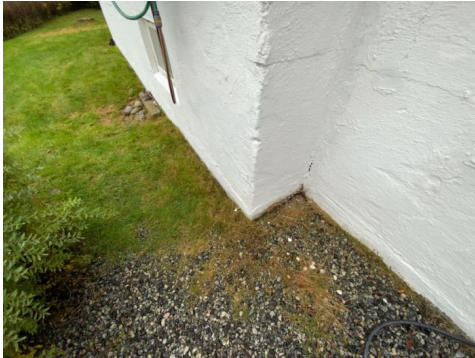
Kontroll av drenering/fuktsikring.
