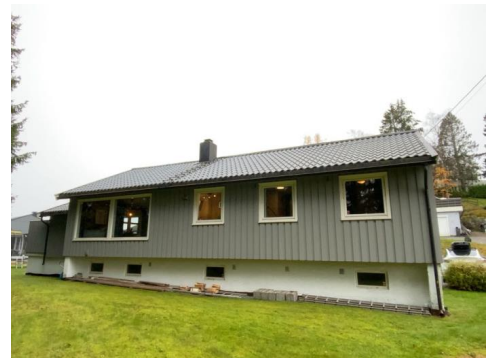
Besiktigelse av taktekke.
