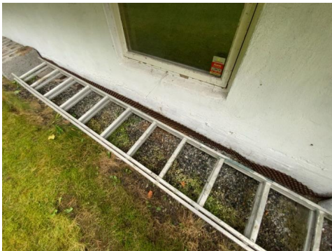
Kontroll av drenering/fuktsikring.
