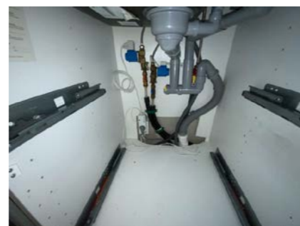
Besiktigelse av røropplegg.
