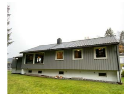
Besiktigelse av taktekke.
