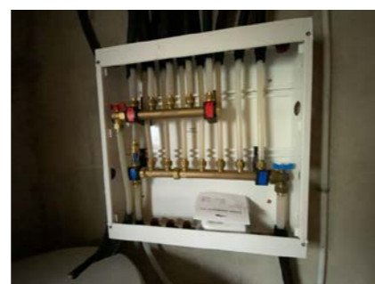
Besiktigelse av røropplegg.
