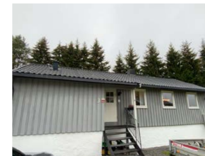
Besiktigelse av taktekke.
