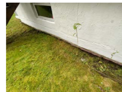
Kontroll av drenering/fuksikring.
