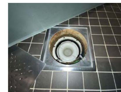
Kontroll av sluk.
