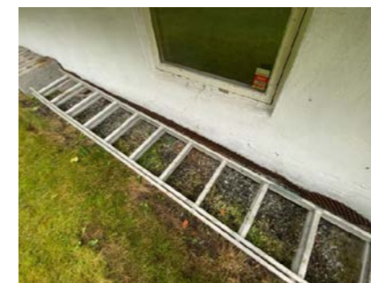
Kontroll av drenering/fuksikring.
