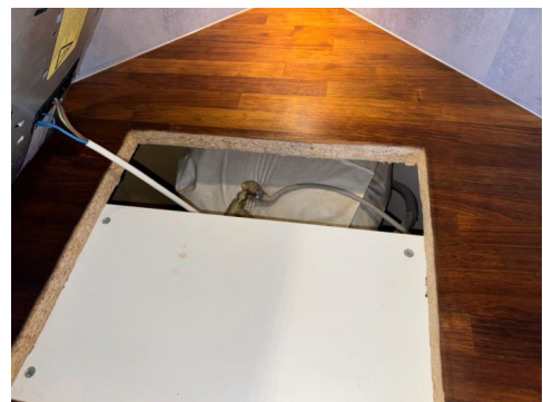
Liten plass for inspeksjon
