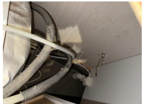
Utilgjengelige stikkontakter og isolerte løse ledninger
