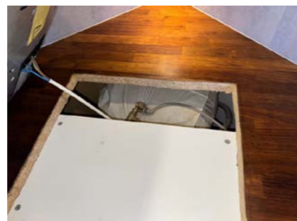
Liten plass for inspeksjon
