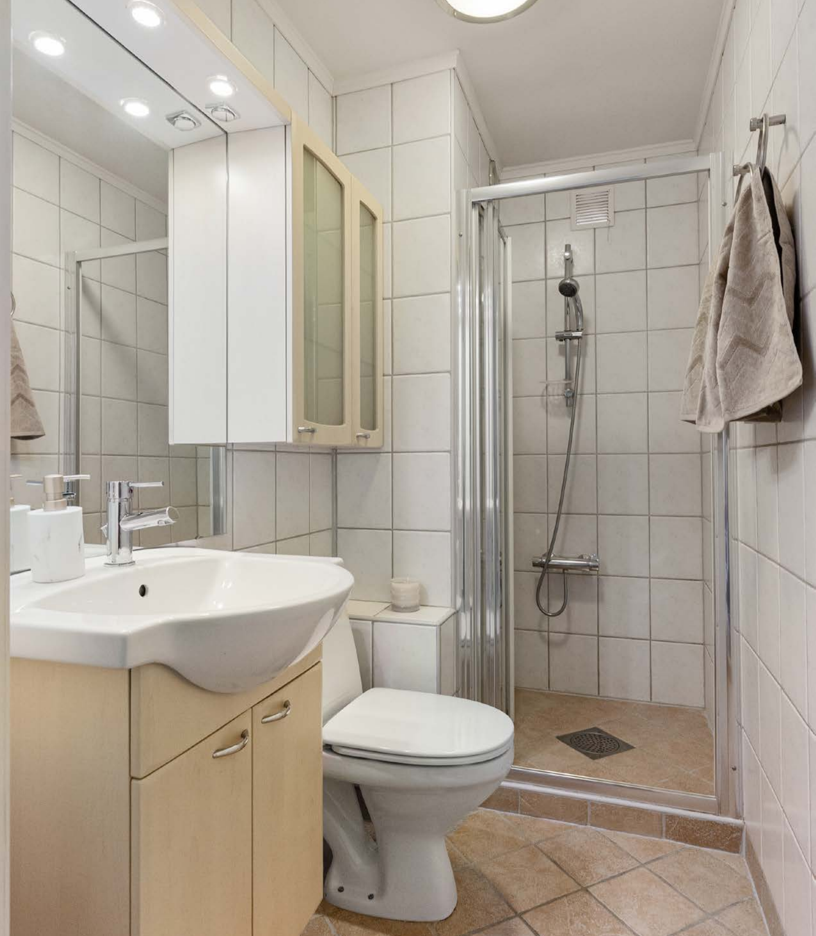
Baderom II har fliser på gulv og vegger og malt himling. Det er montert varmekabler. Badet har gulvmontert toalett, servant med servantskap, speil og to veggskap. Det er praktisk dusjnise.
