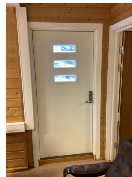
Ytterdør i underetasjen mot øst.
