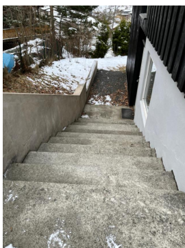
Trapp ned til underetasje på østsiden av boligen.
