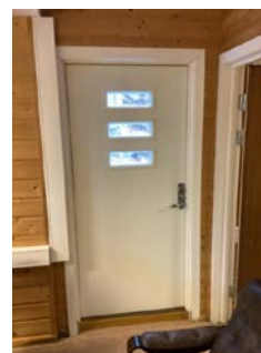
Ytterdør i underetasjen mot øst.
