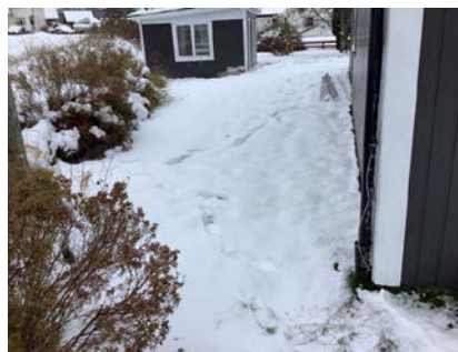
Bildene viser at det ikke er tilfredsstillende fall fra bolig.
