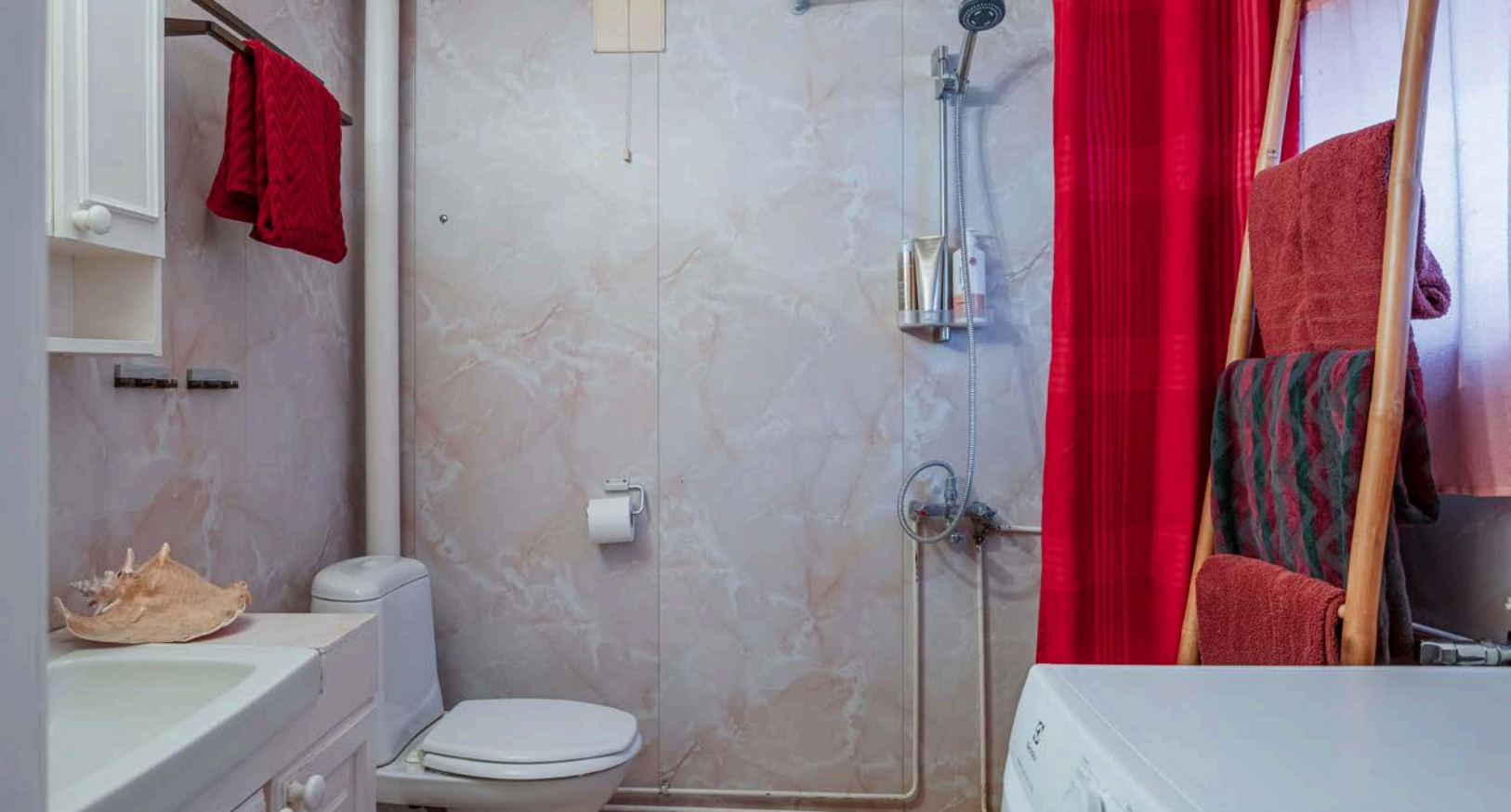
Enkelt baderom med vinylbelegg på gulv med gulvvarme, baderomsplater på veggene og et vindu som slipper inn dagslys.
