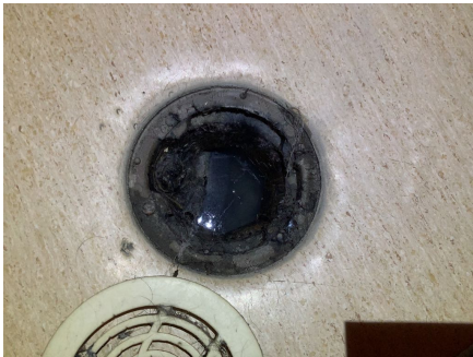
Bildet viser plastsluk og at vinylbelegget er ført under slukets klemring.
