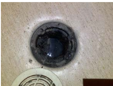
Bildet viser plastsluk og at vinylbelegget er ført under slukets klemring.
