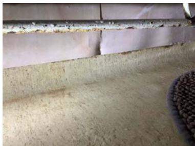
Fuktskadet baderomsplate.
