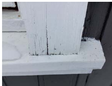
Bildet viser at omramming er ført helt til vannbrett, og dette har ført til oppsprekking.
