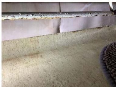
Fuktskadet baderomsplate.
