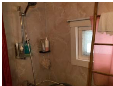
Bildet viser at vindu er plassert i den definerte våtsonen.
