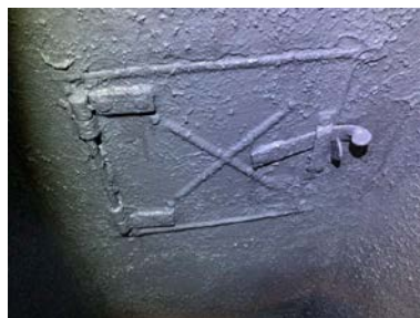
Bildet viser at sotluke er overmalt, og denne lot seg ikke åpne.
