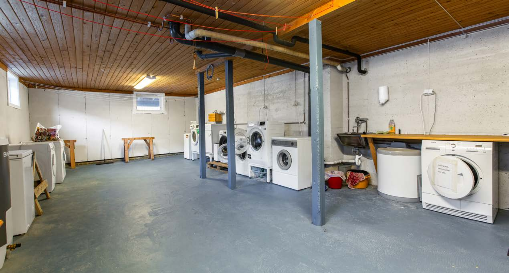
Felles vaskerom i kjelleren
