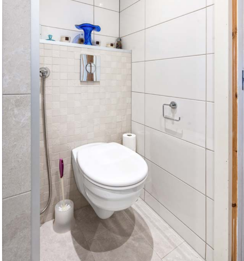
Badet er forøvrig utstyrt med vegghengt toalett, dobbel servant på underliggende skap og speil.
