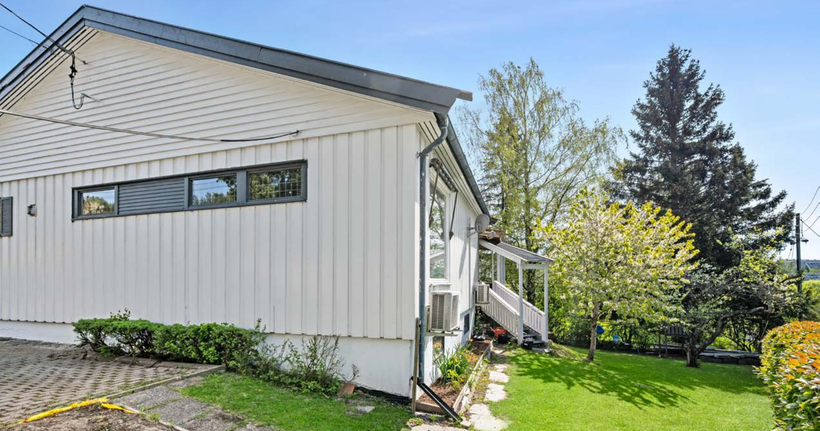
En hellelagt sti fører deg fra innkjørsel til terrasse.
