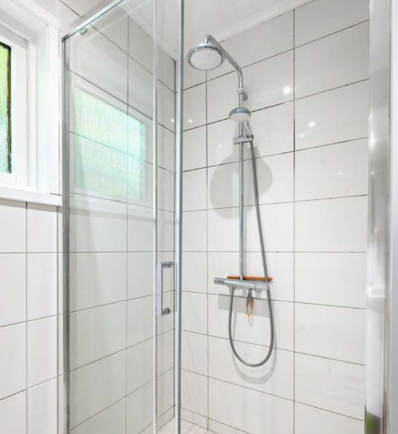
Dusj i egen nisje utstyrt med regnfallsdusj og hånddusj.
