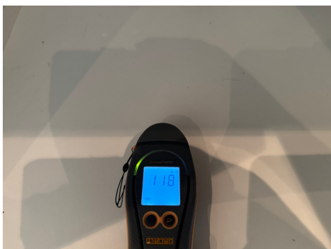
Ingen forhøyede fuktverdier ble registrert i kjøkkenbenken.
