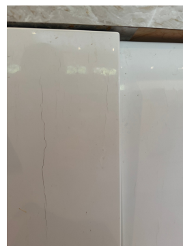
Riss/sprekk i skapfront til oppvaskmaskin.
