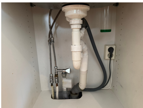
Rørpøpplagg under vask.
