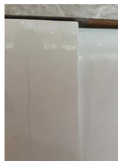
Riss/sprekke i skapfront til oppvaskmaskin.
